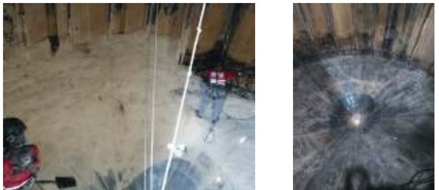
Limpieza de Cilos en piso
